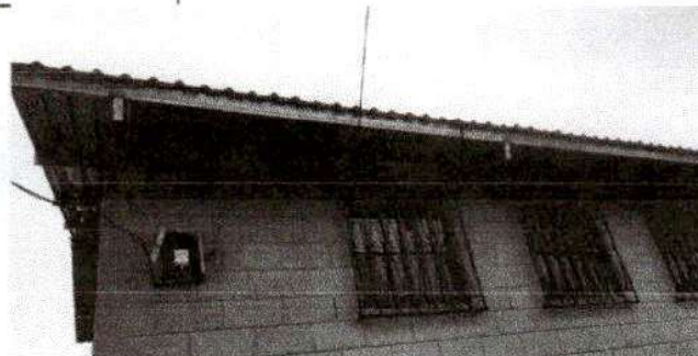
Foto 2: SUSTITUCION DE LAMINA
