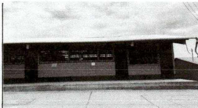
Foto 3: SUSTITUCION DE LAMINA
