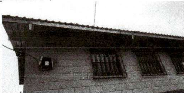
Foto 1: SUSTITUCION DE LAMINA
